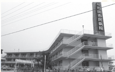
写真7 旧岸和田市民病院
